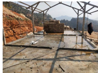
混凝土地面及抗震結構
